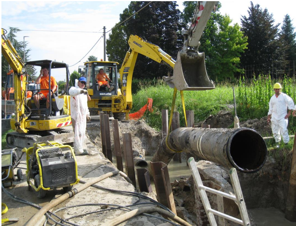
(Manutenzione idrica in Comune di Maserà di Padova – Via Casolina)
